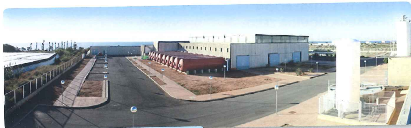
Planta desalinizadora de Almería. | Almería desalination plant.
